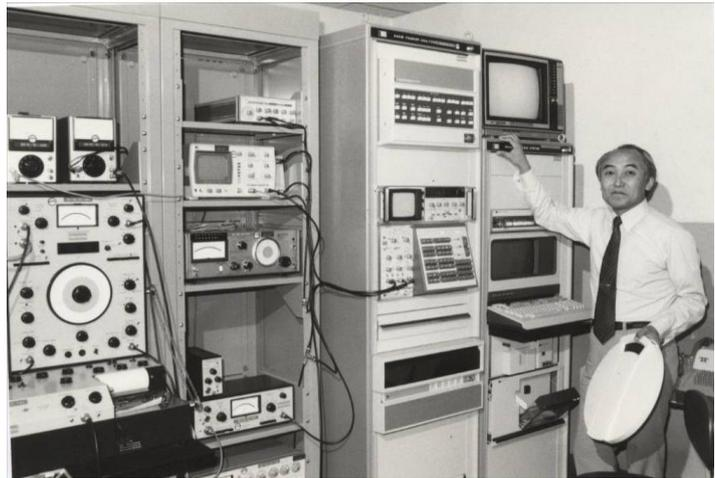
写真-3：設置したFFT装置を前に立つ筆者手に持つのは当時の磁気ディスク
