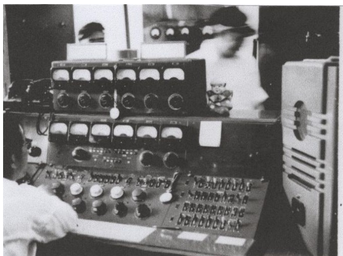
写真 1. NHK 松山中央放送局の調整室で見た NHK II 型試聴機。右端のエンクロージャーの中に P-62F 型スピーカーが搭載されている (1952 年筆者撮影)
