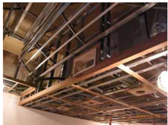
天井の骨組み
