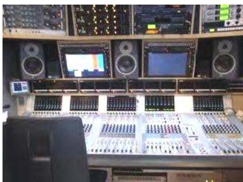
入力は20カメラまで可能で、VTR はラックに必要な台数を実装できるような構造になっている。音声モニターは、5.1ch に対応、SW席の音声もサラウンドでモニターできる。上の写真は0B-VAN内部である。連絡系はRTSでマトリクスを組んであり、必要な箇所に必要な連絡系を構築することができる。
