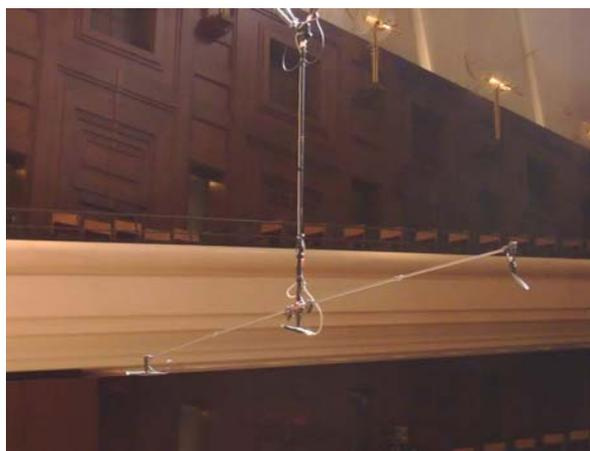
写真2 フィリップス方式メインマイクの実際
