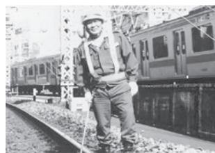
今日では、レールの傷は超音波を利用したレール探傷車で対処しているが、導入以前は小ハンマーによる打音で判定を行っていた。現在でも探傷車の運行がない線路に対しては同様の方法で保線業務を実施している。またレール間をつなぐ継目板のボルト緩みも、ハンマー等による「音響」で発見し、締め直しを行っている。同氏は、
