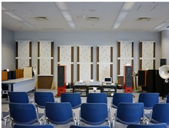
ヤマハさんの全面協力により設置された全 30 枚の調音パネル
