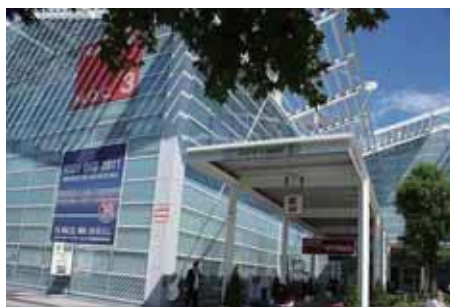
(写真 23) 会場の建物外観
